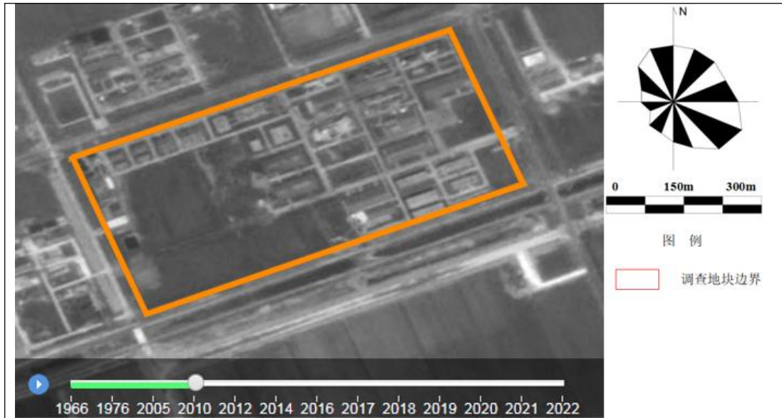
摄于 2010 年，兄弟维生素厂区已完成建设
